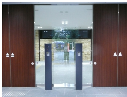
<風除室内カードリーダー>
